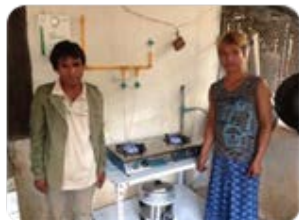
อุปกรณ์หุงต้มเชื่อมเพลิงแก๊สชีวภาพ
