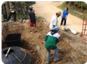
การติดตั้งบ่อแก๊สชีวภาพ
